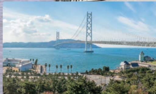
明石海峡大橋
