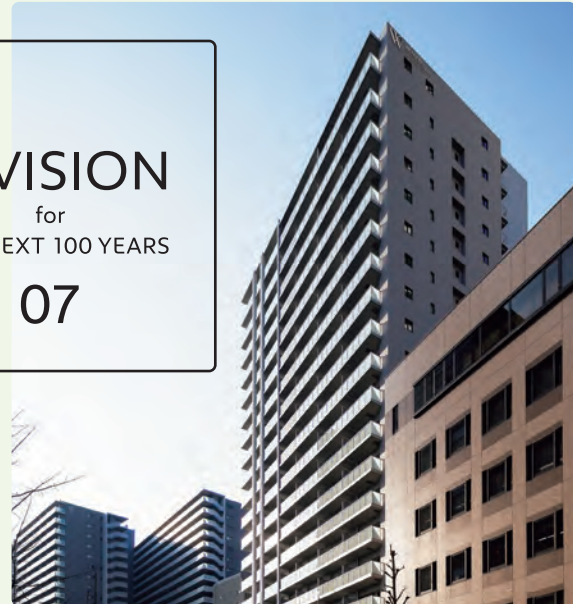
ワコーレ神戸三宮トラッドタワー
