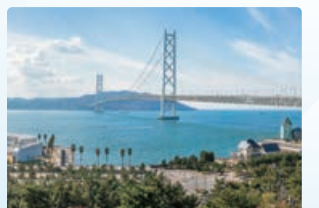
明石海峡大橋
